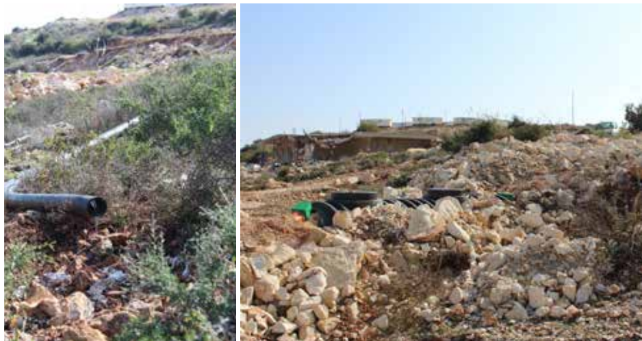
תמונות 14-15: שכונת קרוואנים ליד עטרת: מיכל ספטי (בור רקב) וציאת ניקוז לשפך הנזולים על גבי הקרקע
